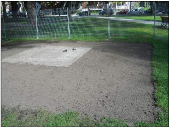
Recouvrement du Bod Pave 85 avec de la poussière de roche.
