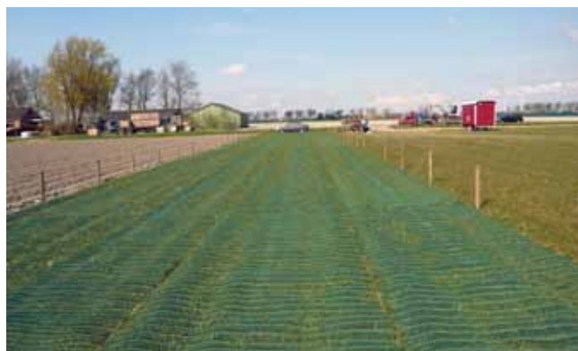
Installation de GRASSPROTECTA pour parking
