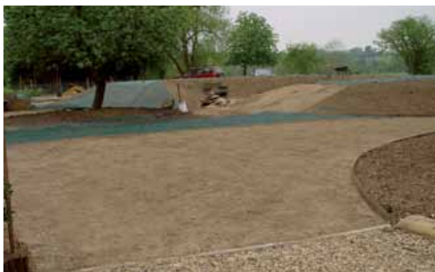
Installation nouvellement aménagée avec du TURFPROTECTA vert recouvert d'une couche de terre végétale et de semences.
